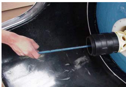
Stap 2: De onderdelen uit stap 1 zijn gemonteerd (buiten de tank) en met extensie I-WR03-LA in de tank ingebracht.
