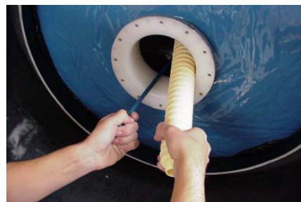
Stap 3: Plaats de gemonteerde assemblage in de tank om de verdeelarmen aan te brengen.
