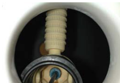
Stap 4: Schroef alle dwarsleidingen in de hub terwijl u de extensie nog vasthoudt.
