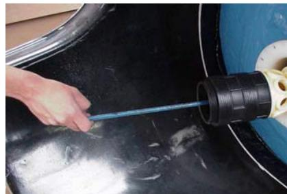
Paso 2: Las piezas mostradas en el Paso 1 se montan (fuera del depósito) y se introducen en este mediante la extensión I-WR03-LA.
