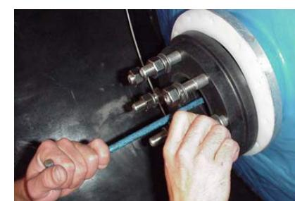
Paso 5: Atornille el adaptador de brida al conjunto. Asegúrese de que la junta tórica esté correctamente fijada y sellada al adaptador.
