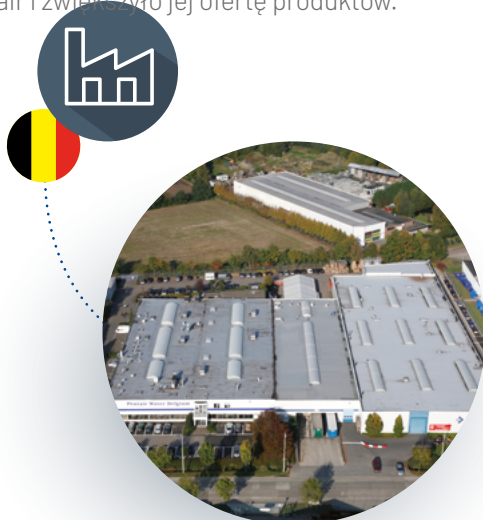
Zakład produkcyjny Structural Herentals, Belgia
